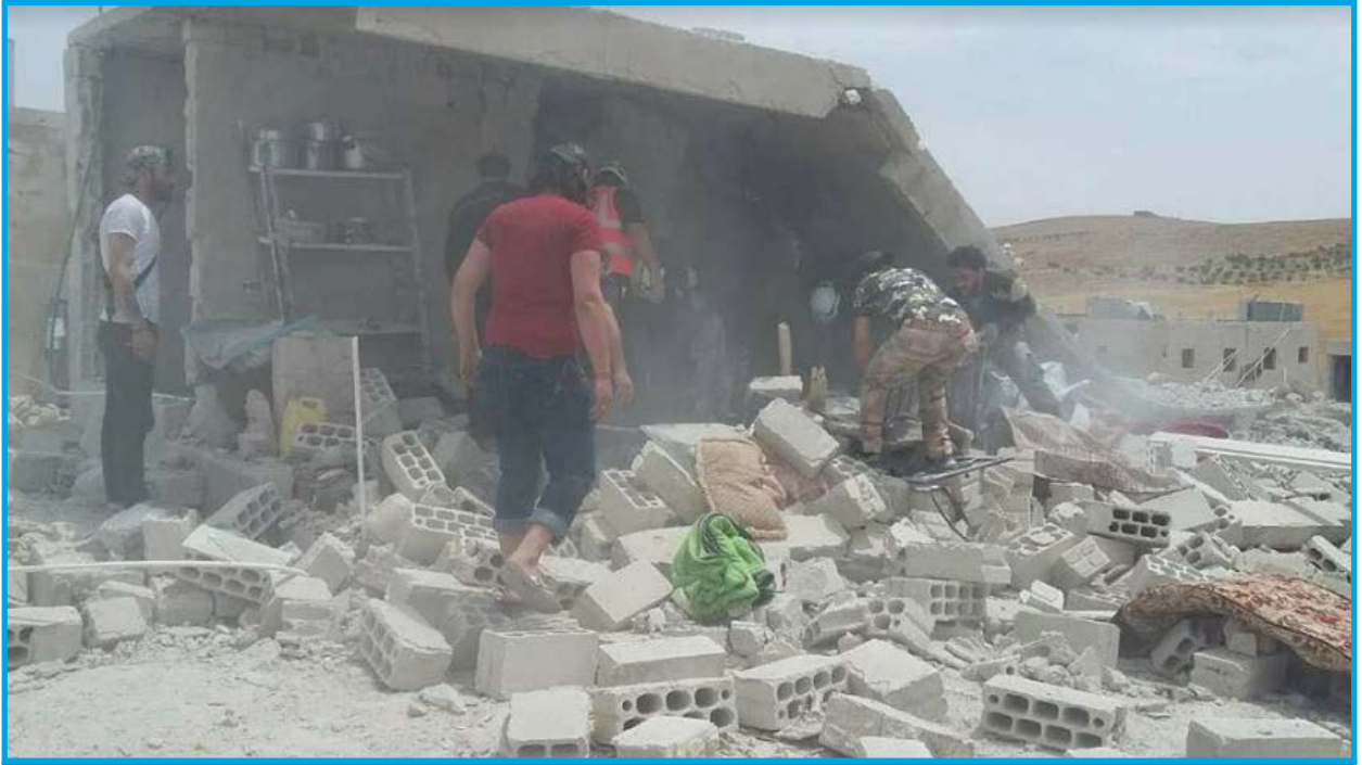
دمار في مساكن منطقة الشياح بعد القصف الجوي الذي نفذته قوات النظام السوري 30 / 4 / 2017
